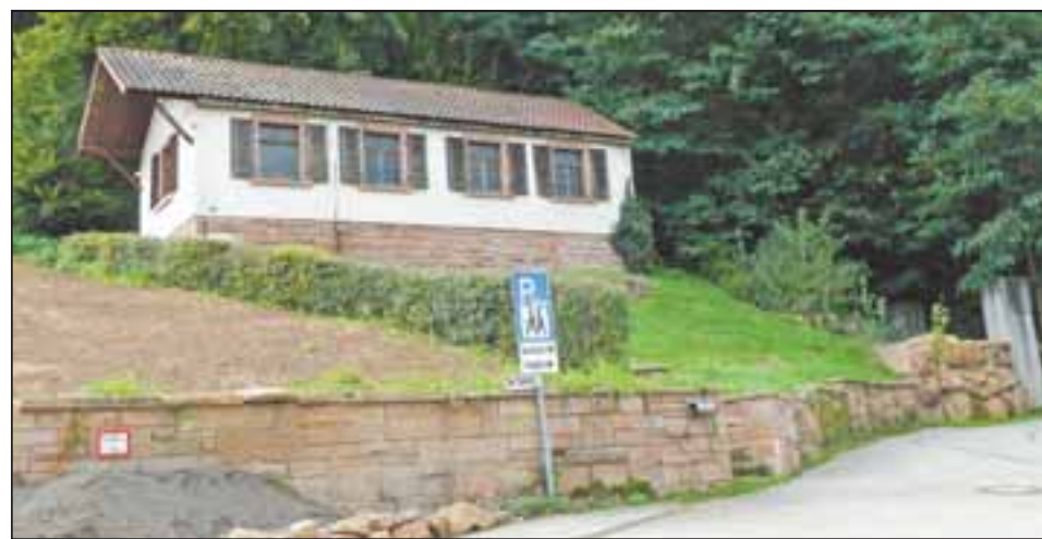
Das ehemalige Schmelzer-Bürogebäude, das zusehends dem Verfall preisgegeben ist, soll nun doch abgerissen werden. Ein Verkaufsversuch scheiterte. Foto: Deschner
