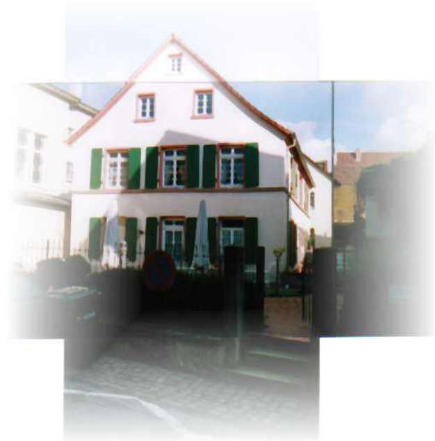
Ansicht: Mittlere Kirchgasse
